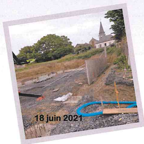
Construction de la nouvelle école
