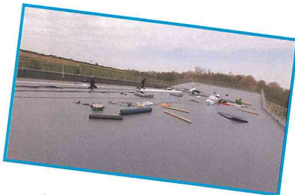
Étanchéité de la toiture de la Salle de l'Orion
