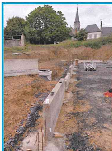
Le terrassement et les fondations
